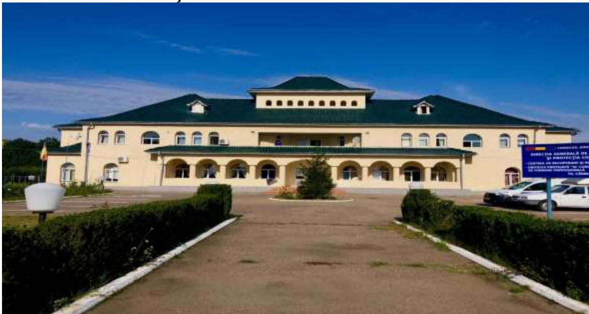
Centrul de Recuperare și Reabilitare Tg-Cărbunești, scurt istoric:
